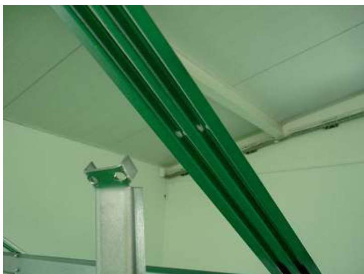
Spojení střešní výztuhy (24) a střešního sloupku (15).
