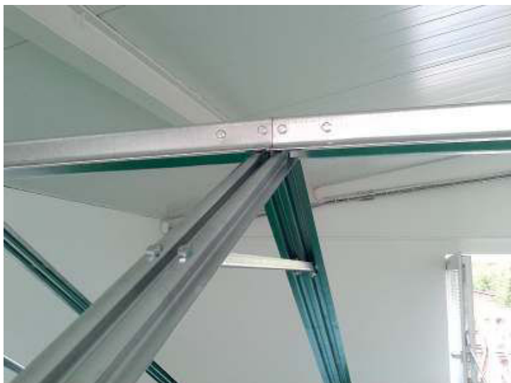
Pohled na hřeben skleníku.
